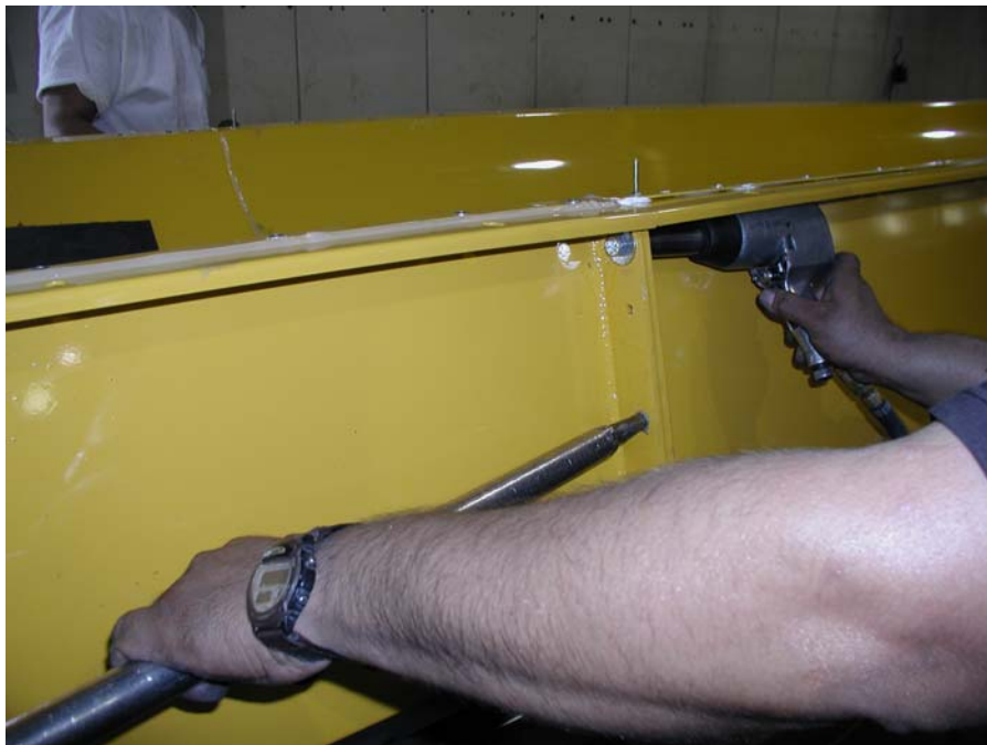
Paso 12: Conecte las secciones con pernos de brida. Utilice una varilla de alineación si fuera necesario. Luego retire las varillas de conexión y reemplácelas por el perno de brida adecuado.
