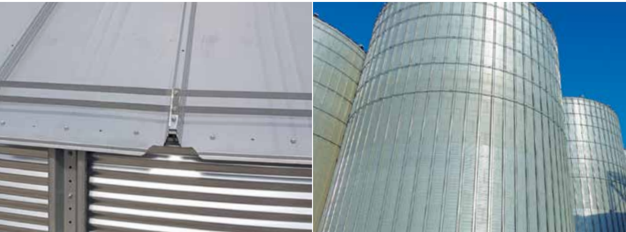
Schneebarrieren werden aus verzinktem, profiliertem und perforiertem Stahl hergestellt. Sie können an die Dachtraufen montiert werden.
