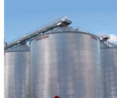
Silos comerciales de cereales
