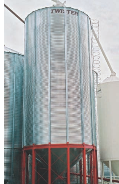
Silos comerciales con tolva
