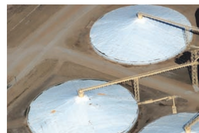
Almacenamiento a granel permanente
